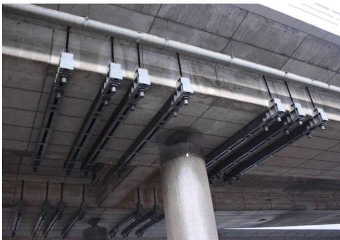
Schubverstärkung des Tausendfüßlers
